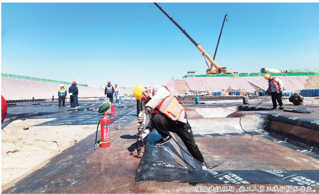
项目施工现场,施工人员正在进行防水作业。
