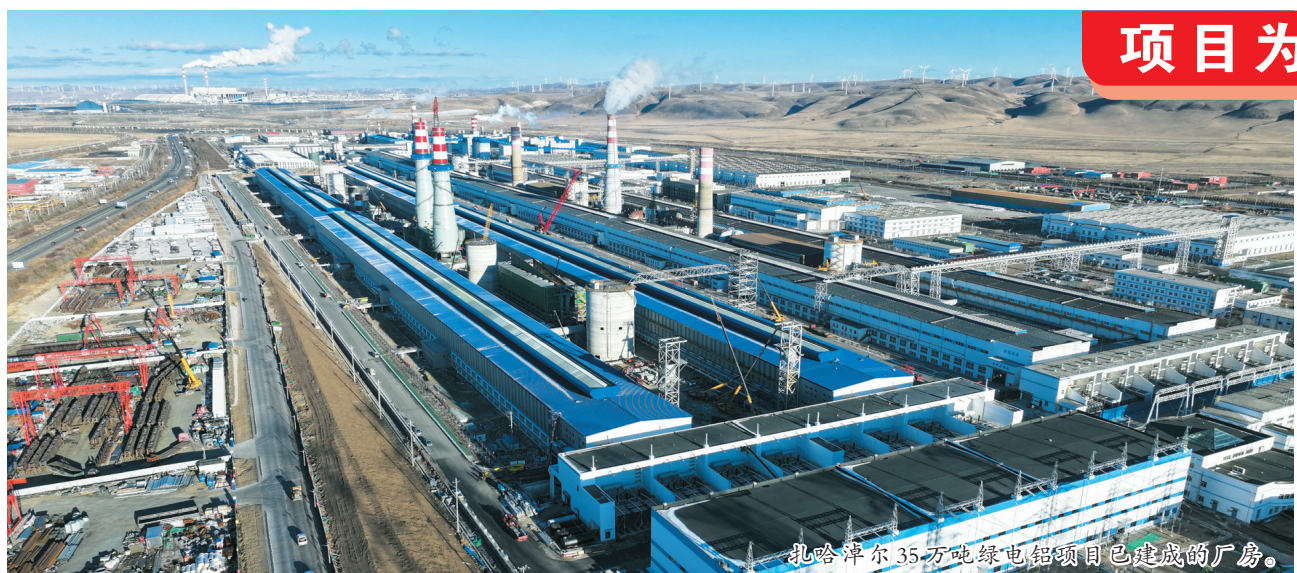
扎哈淖尔35万吨绿电铝项目已建成的厂房。
