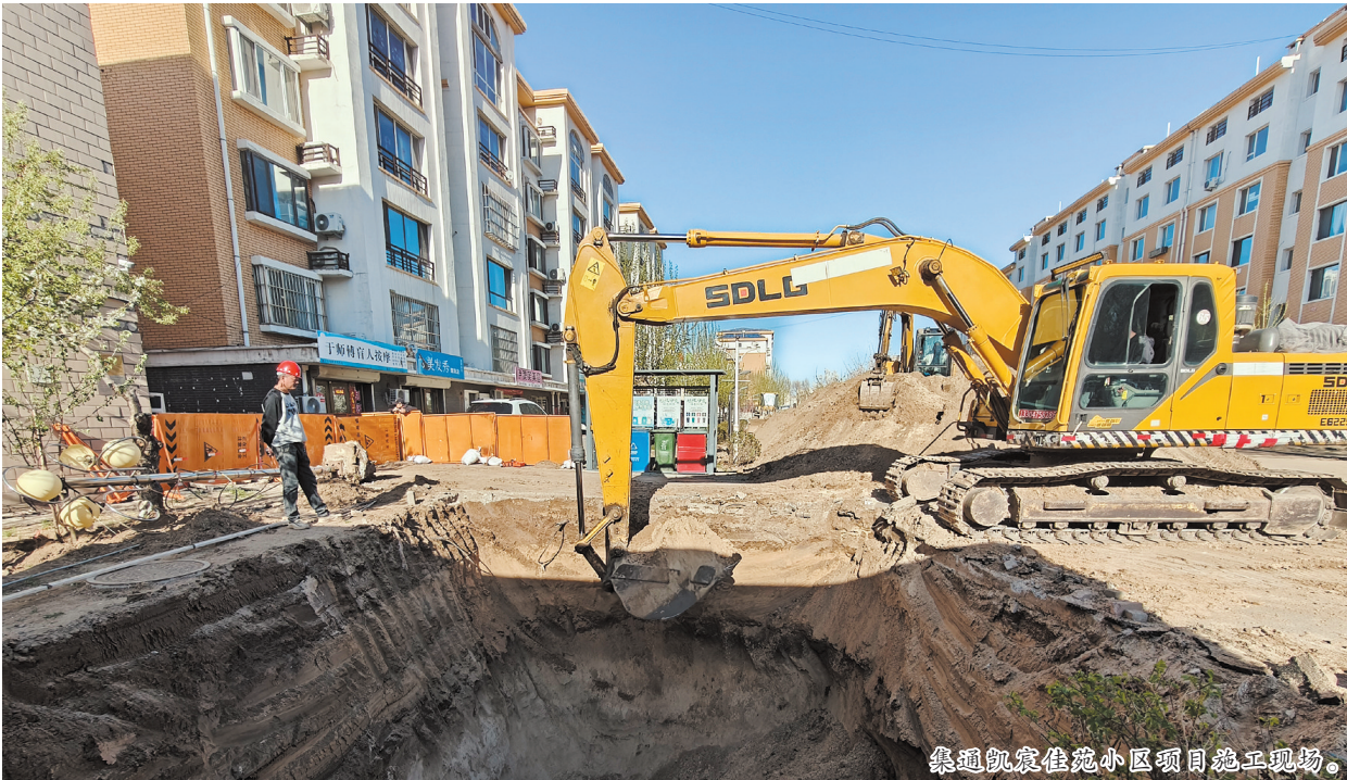
泰通凯宸佳苑小区项目施工现场。
