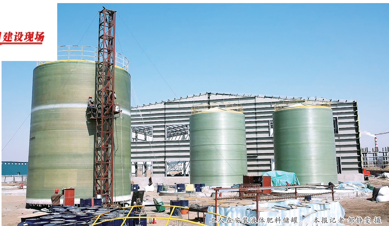
工人在安装液体肥料储罐。本报记者 邹静雯 摄
