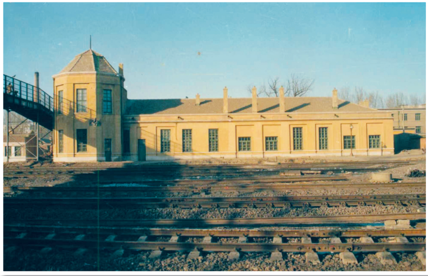
原打通路通辽站站舍,1978年7月1日通车车务段段舍。1992年11月拆除
