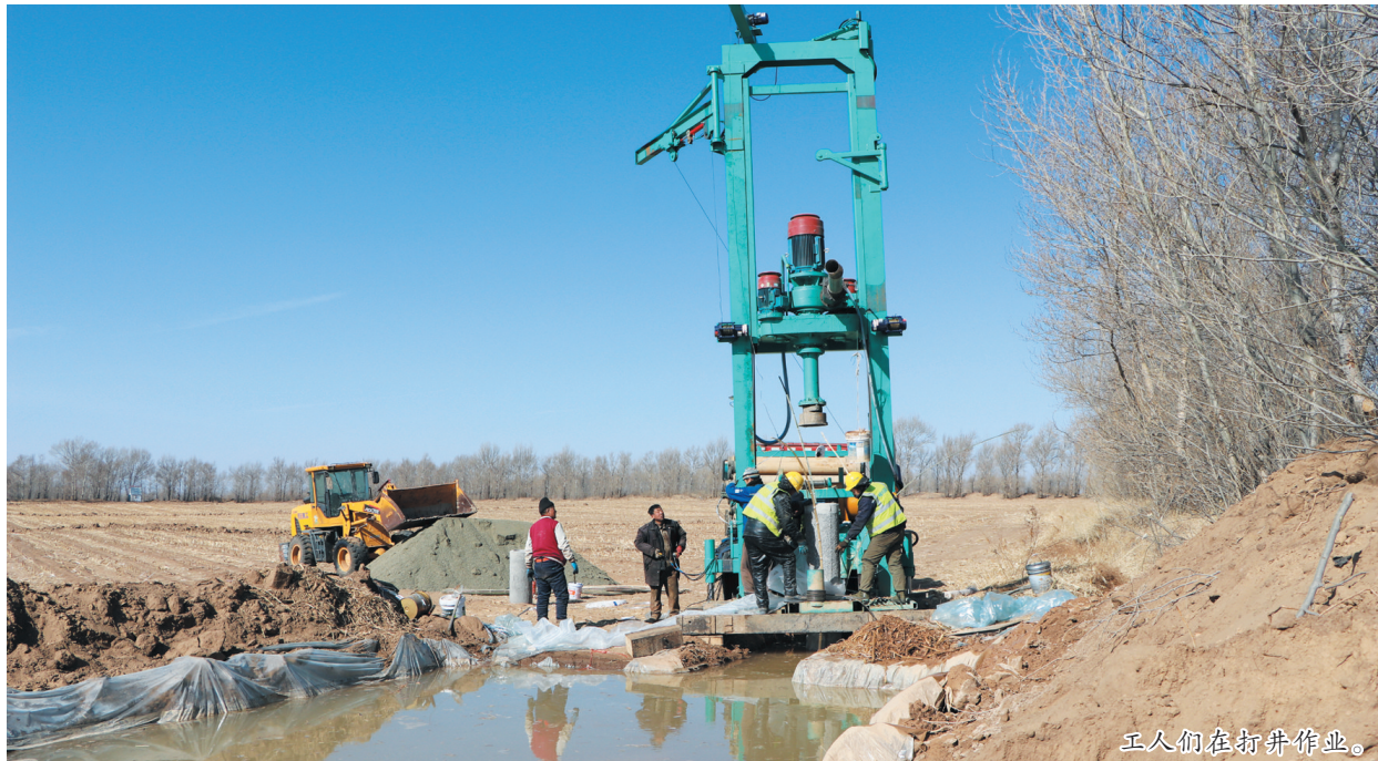
工人们在打井作业。
