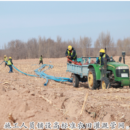
施工人员铺设高标准农田灌溉管网。
