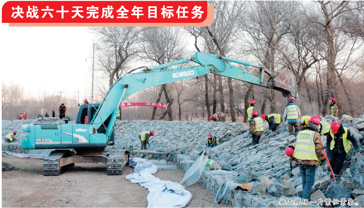
施工现场一片繁忙景象。
