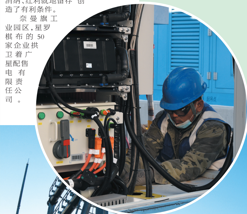
◀工人正在调试储能设备。
