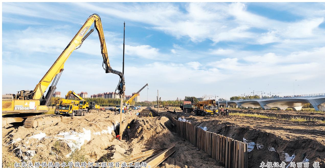
红光大桥供热供水管线跨河工程项目建设现场。
