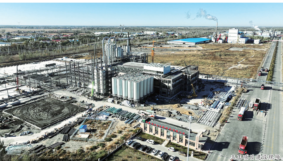
玉王项目建设现场。
