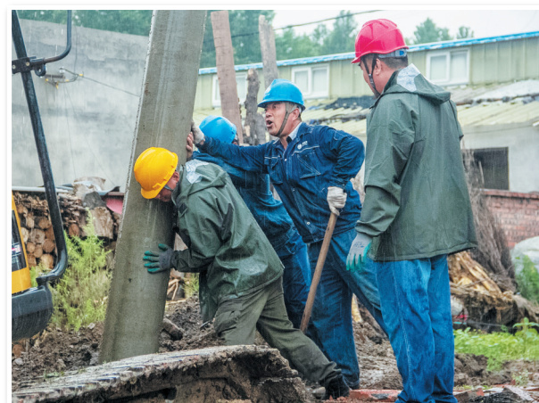
在雨中对杆塔进行扶正。
