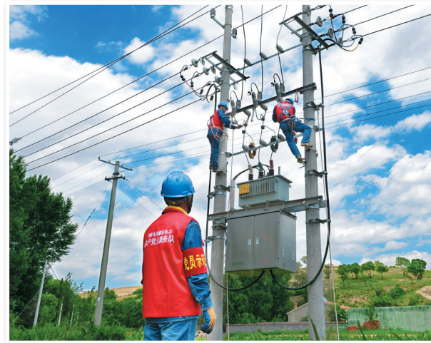
对变压器台区进行升级改造。
