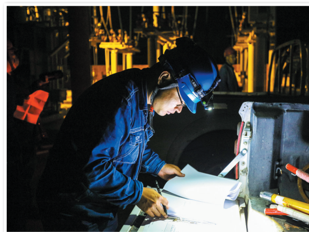
在66千伏太山变电站开展“零点作业”。
