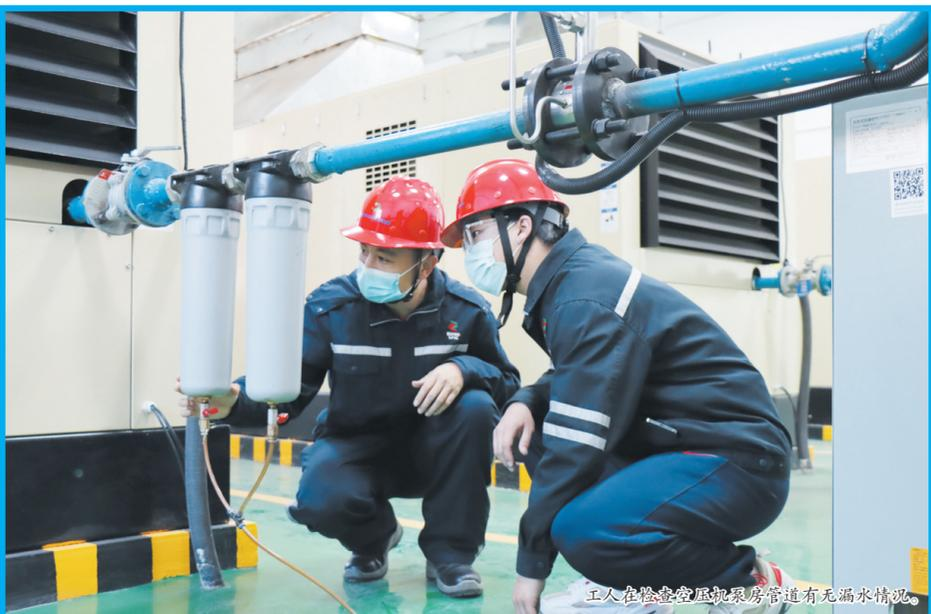
工人在检查空压机泵房管道有无漏水情况。
