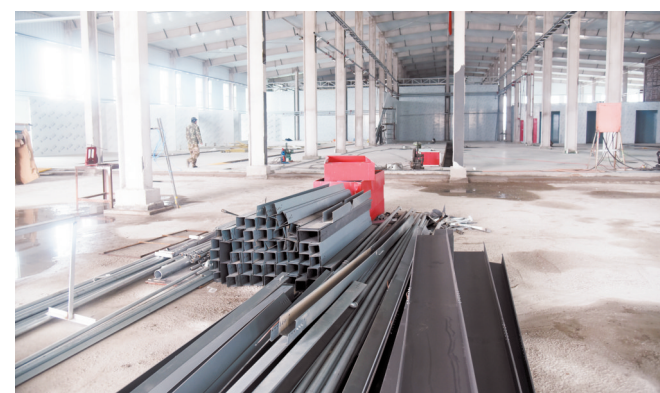
蒙乡情食品有限公司3000吨牛羊深加工项目(后旗) 科左后旗2020年通过招商引资引进该项目,项目总投资1亿元,占地面积58亩,分二期建设。一期主要建设牛、羊分割车间3000平方米,冷库及包装间等1000平方米,办公及生活用房1600平方米,购置安装牛、羊分割设备500余套,冷库设备设施19台套,并配套建设水、电、暖、场区道路及围护工程。今年3月复工建设,10月份正式投产。项目达产后,年可实现产值1亿元,上缴税金800万元;二期计划建设牛、羊肉熟食制品车间3000平方米,购置安装牛、羊肉熟食制品加工设备设施87台套。项目全部达产达效后,年可实现产值2亿元,上缴税金1200万元,带动牛羊肉制品相关企业10家以上,提供就业岗位300个。
