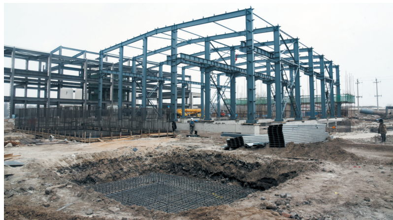
泰鼎有色金属加工有限公司年处理15万吨废铅酸蓄电池综合利用项目(后旗) 为进一步提高生产规模,2018年,通辽泰鼎有色金属加工有限公司投资1.6亿元建设年处理15万吨废铅酸蓄电池综合利用生产线项目,引进全自动电瓶拆解线和自动电瓶壳破碎分离清洗生产线各一条,年可处理铅酸蓄电池15万吨,生产铅及铅合金10万吨、PVC塑料颗粒1万吨、脱硫石膏1.8万吨。2021年实现工业总产值9.1亿元,上缴税金919万元。今年,公司投资2.48亿元,建设再生铅产业升级、锂电池回收利用及副产品资源化利用绿色工厂项目。项目已于5月1日起开工建设,计划2024年12月建成投产。全部达产达效后,预计年实现工业总产值20亿元、税收2000万元,提供就业岗位350个。
