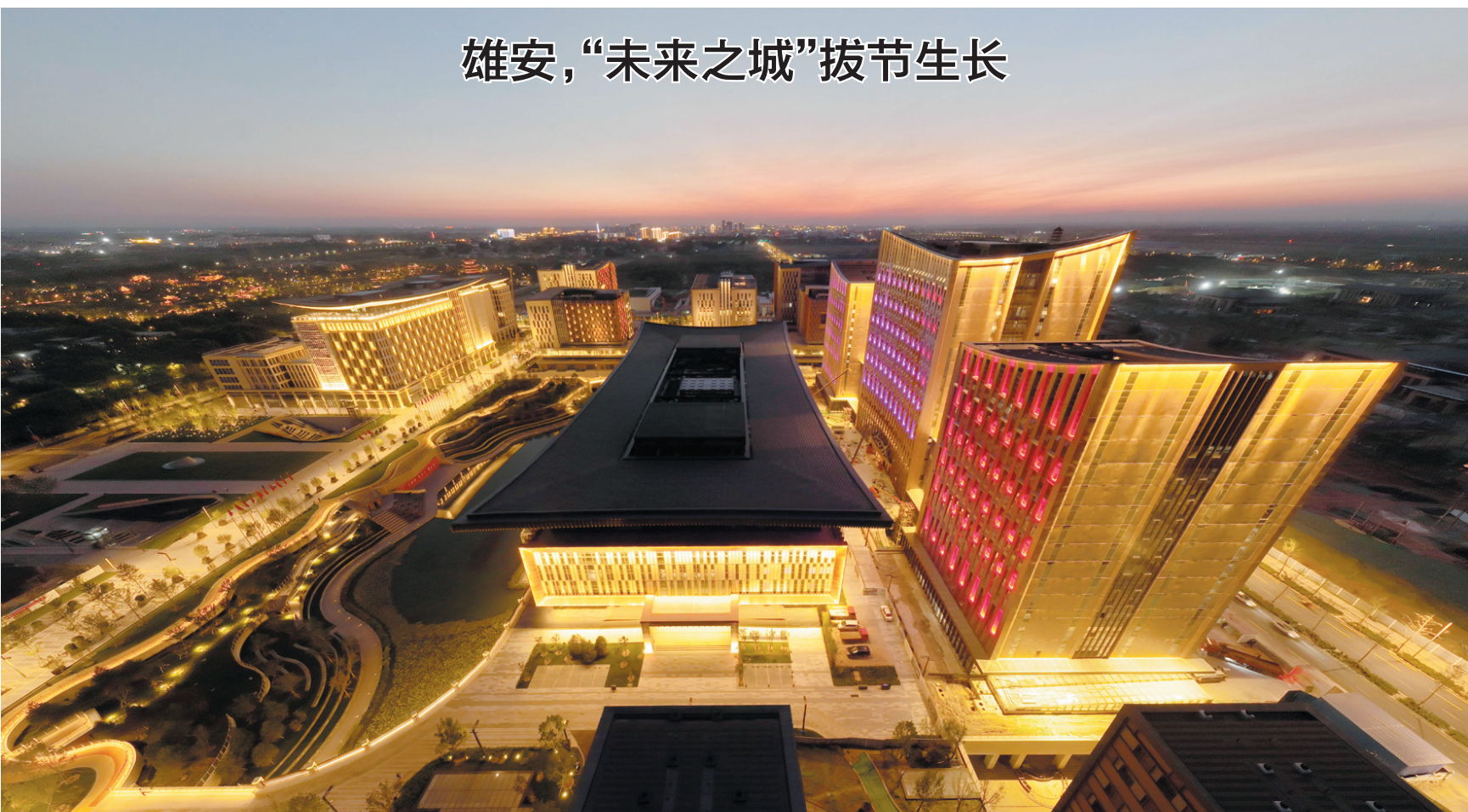
2022年9月7日拍摄的雄安新区商务服务中心(无人机照片)。
