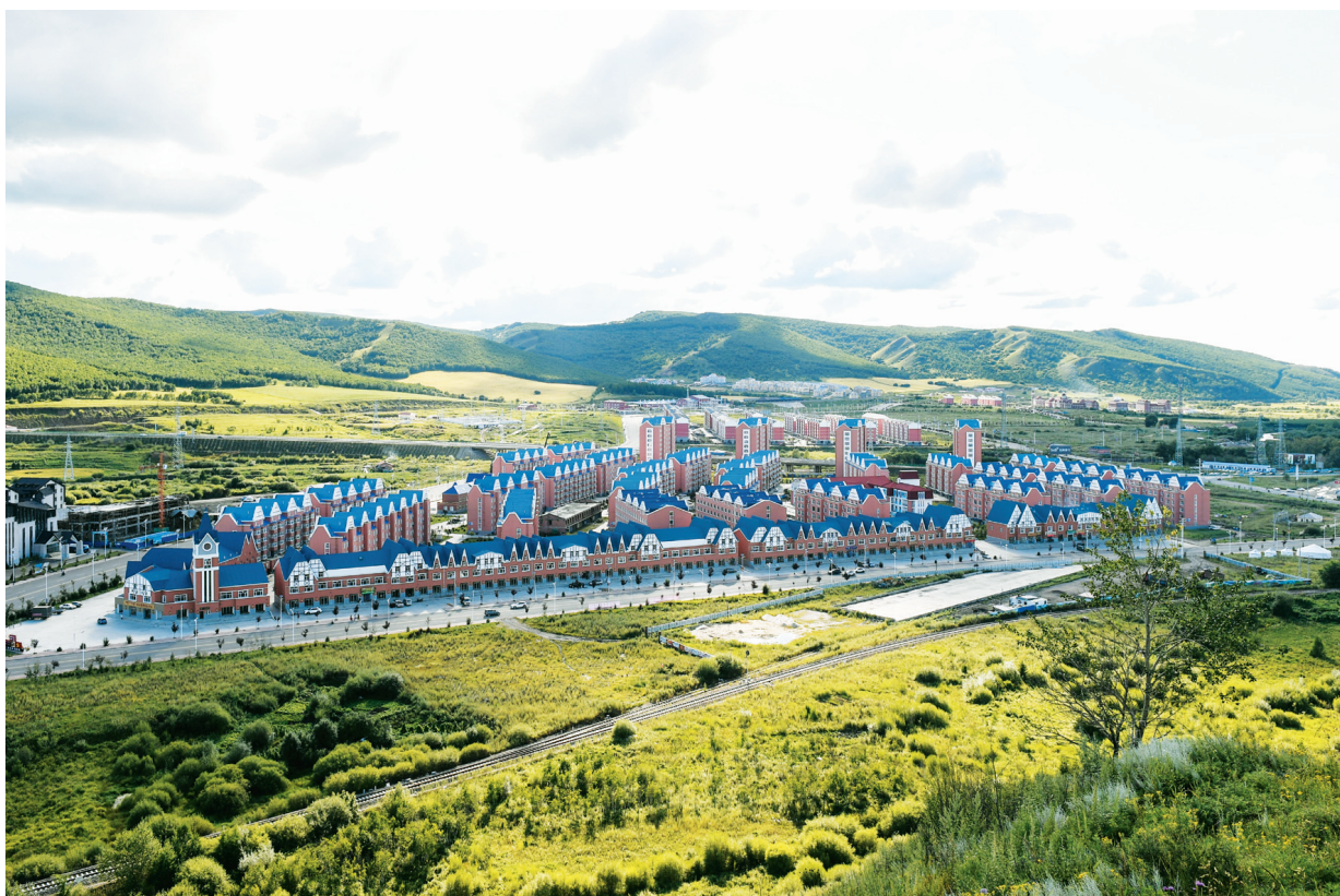
内蒙古阿拉善市一处棚改集中安置点(2019年8月12日摄)。
