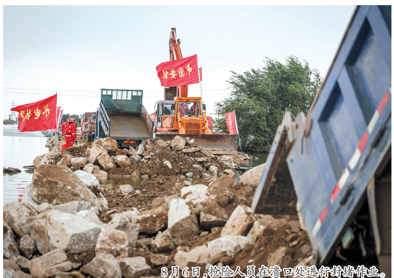
8月6日,抢险人员在溃口处进行封堵作业。
